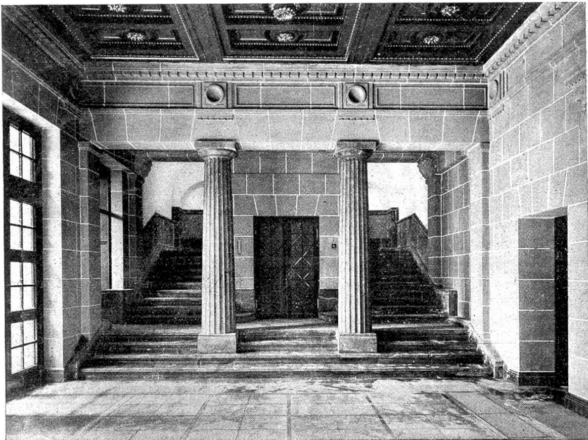
Parterre-Vorhalle im „Münzhof“ zu Zürich mit Säulen aus Granit von Andeer und Treppen aus Collombey-Marmor.
