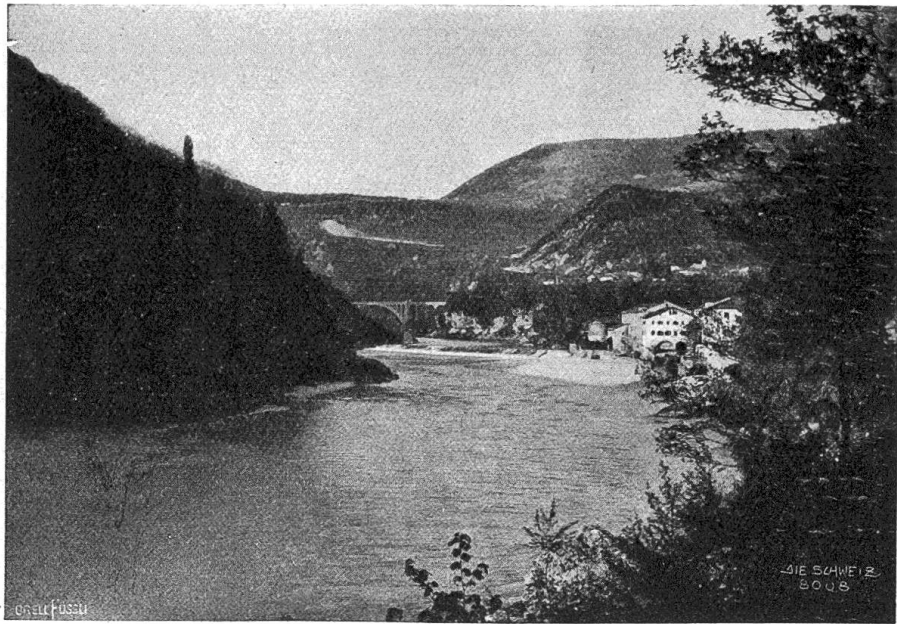
Eisenbahnbrücke bei Görz (Linie Görz-Höfling), im Hintergrund der Karft.
