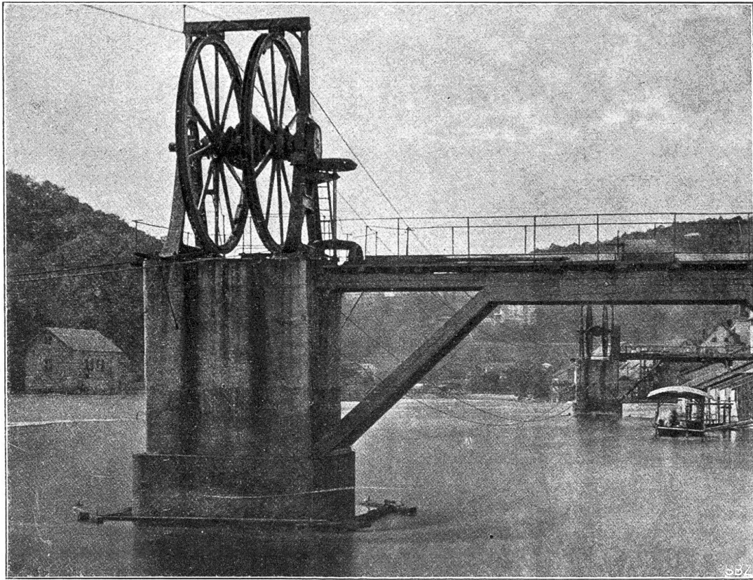
Schaffhauser Wasserwerke. Pfeiler III der alten Transmissionsanlage.
