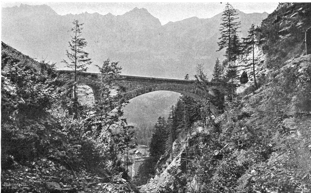
Lötschbergbahn: Brücke oberhalb Mittholz.
