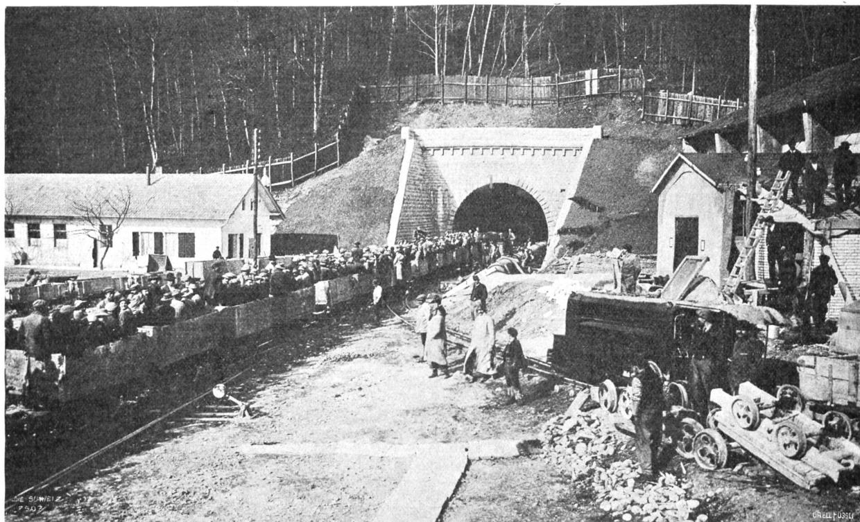
Vom Bau des neuen Hauenstein-Basistunnels. Das südliche Portal bei Olten mit einfahrendem Arbeiterzug. Phot. Anton Krenn, Zürich.
