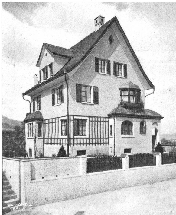
H. Suber, Zürich.
