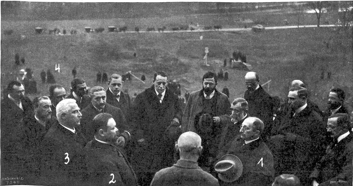
Der Beginn des Tunnelbaues am Hauensfein. Der feierliche Moment des ersten Spatenstichs (l. Teg). Phot. A. Kamm, Zürich.
