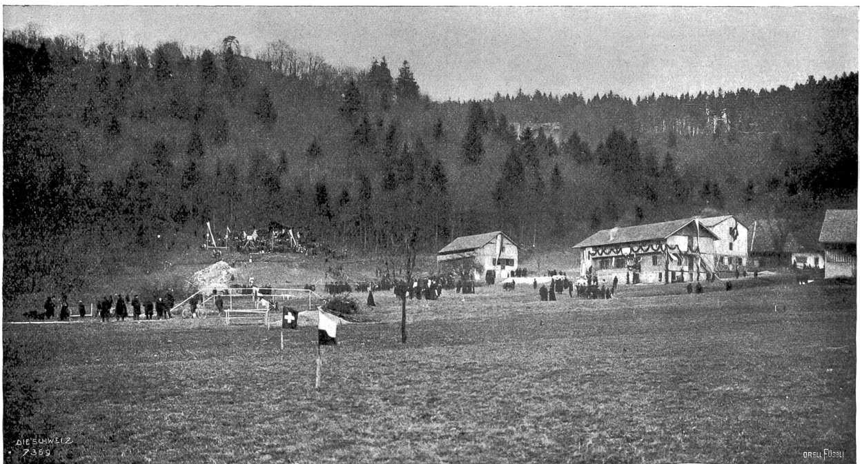
Der Beginn des Tunnelbaues am Hauenstein: Der Tunnelzugang bei Hauenstein. Phot. A. Krenn, Zürich.
