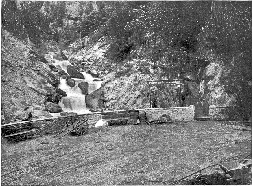
Die erste Kehre der Bristenstraße (Uri) mit Blick auf den Kerstelenbach.
