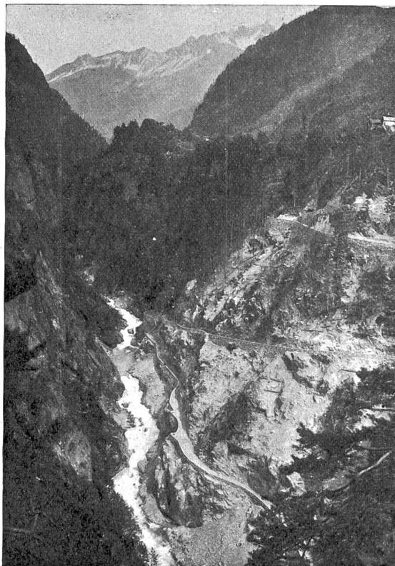
Die neue Bristenstraße bei Amsteg.
