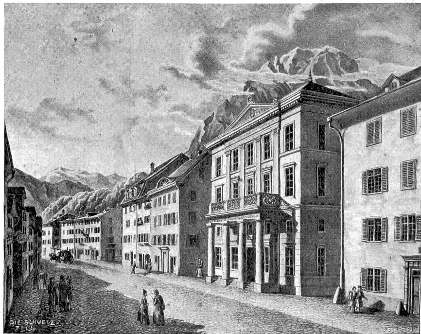
Regierungsgebäude des Kantons Glarus vor dem Brande. Nach einem Aquarell von Ganggner.
