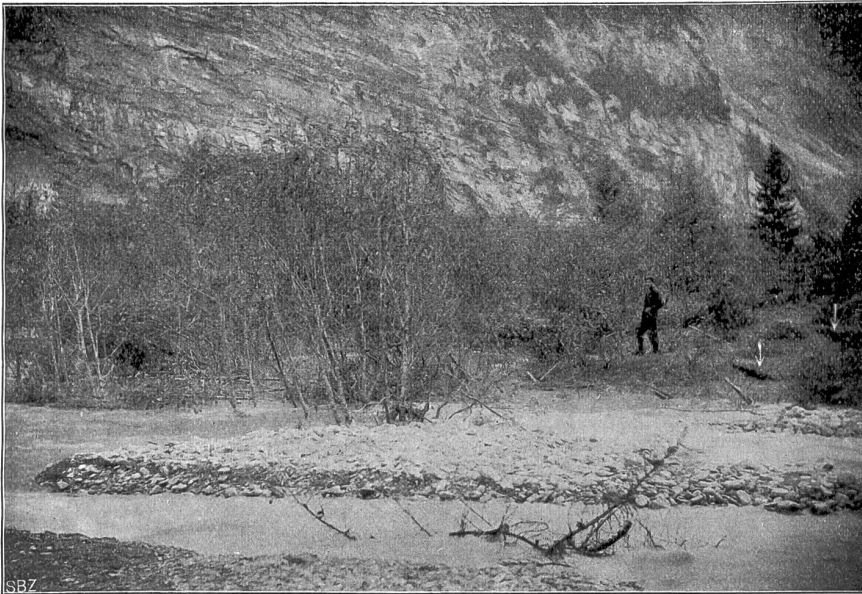
Der Einspurtrichter im Gasterntal über dem alten Tunnel. Aus der Schweiz. Bauzeitung.
