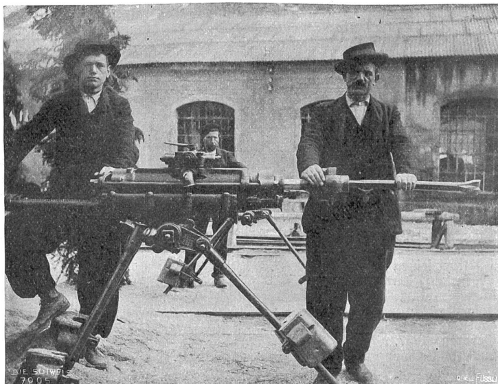
Bohrmaschine durch komprimierte Luft getrieben. Phot. W. Zollinger, Zürich.
