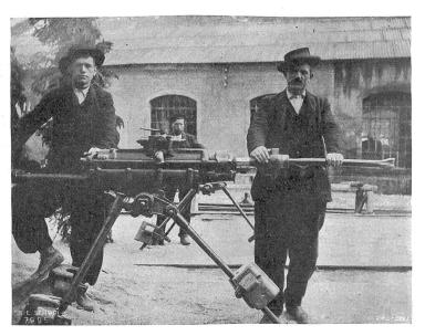
Bolyxmaschine durch komprimierte Luft getrieben. Phot. W. Zollinger, Zürich.
