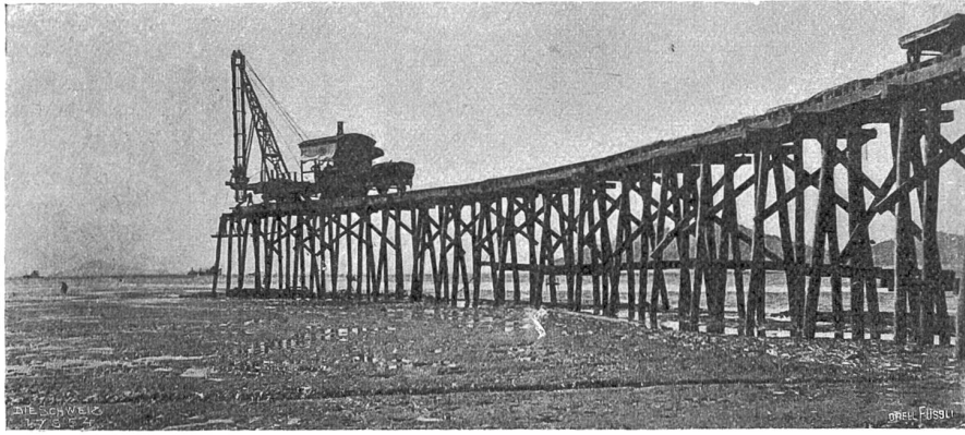
Vom Panama-Kanal Abb. 8. Gerüst zum Schütten eines Hafendamms, in der Bucht von Panama.
