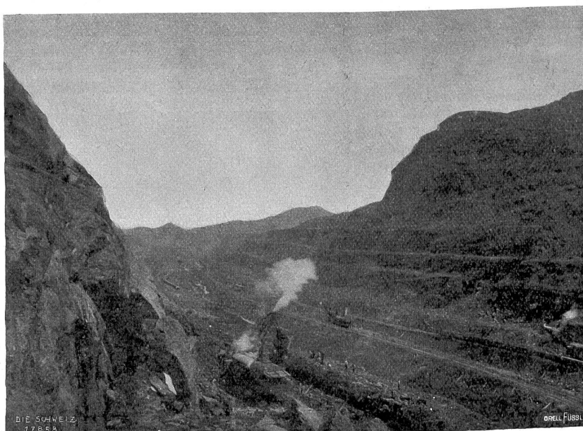
Vom Panama-Kanal Abb. 7. Culabra-Einschnitt; Dampfschaukel, die gebrochene Felsmaße auf Eisenbahnwagen ladend.
