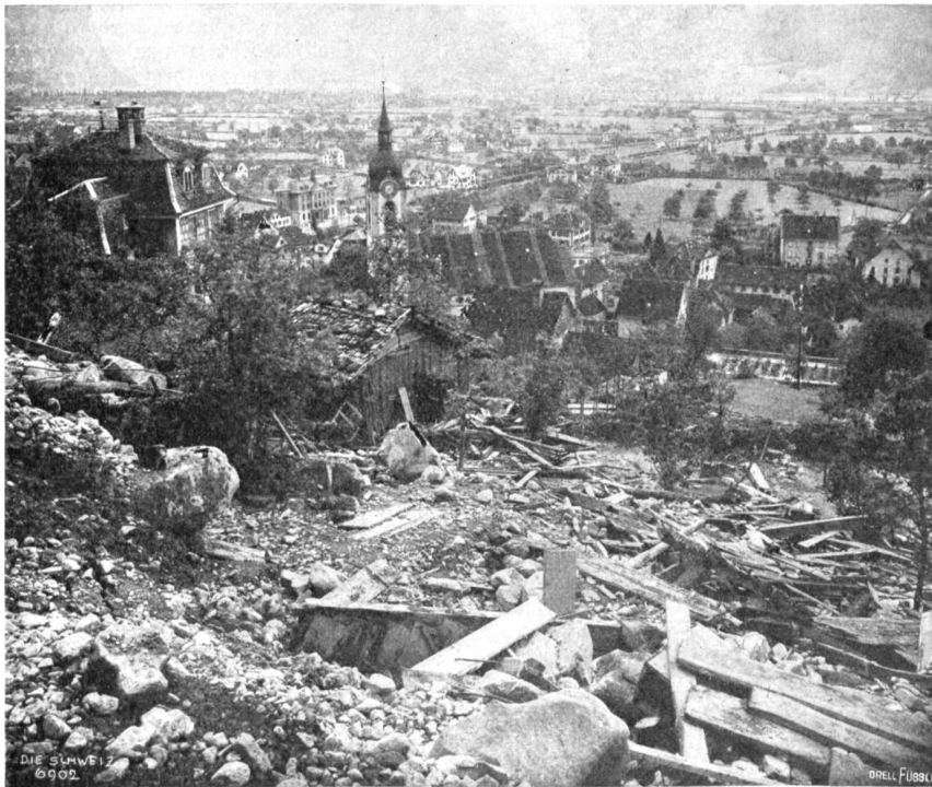
Das durch eine Risse zerstückte Haus in Altdorf, unter dessen Trümmern zwölf Personen den Tod fanden. Phot. Anton Krenn, Zürich.
