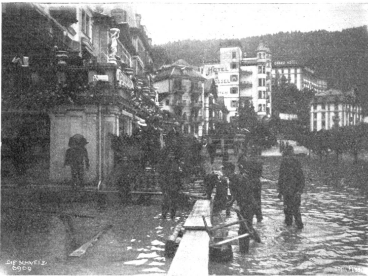
Der überschwemmte Quai in Brunnen. Phot. Anton Krenn, Zürich.
