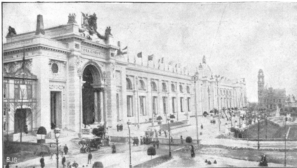
Das Hauptgebäude der Weltausstellung zu Brüssel.
