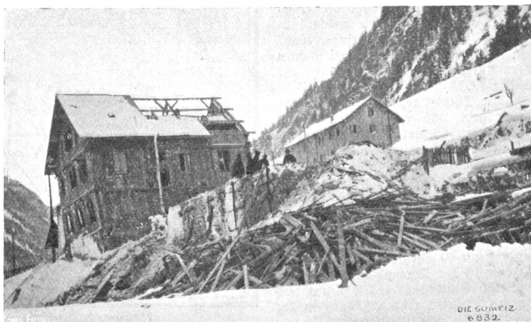
Zerstörung in Goppenstein durch eine Schneelawine.
