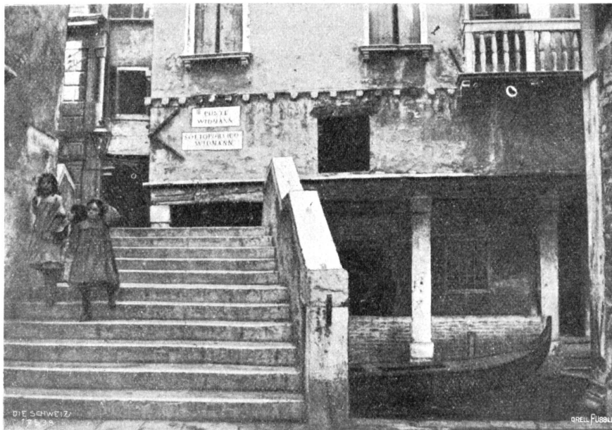
Die Widmannbrücke am Ende der Widmannstraße in Venedig.
