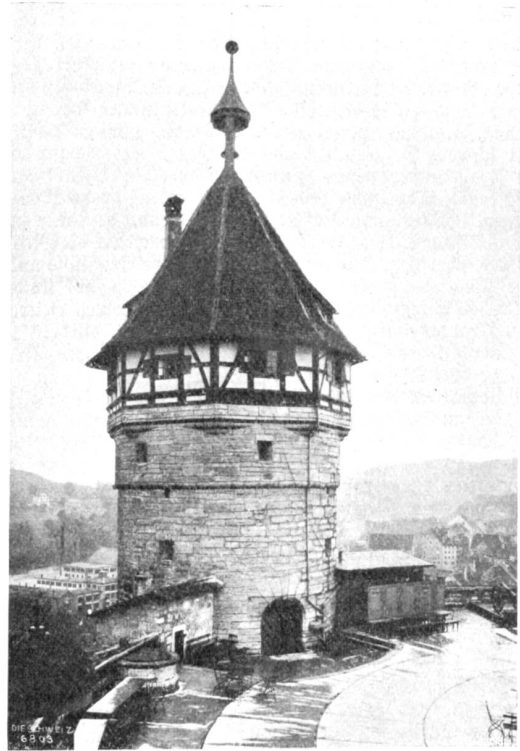
Der Hauptturm des Munot. Phot. H. Lunte, Zürich.
