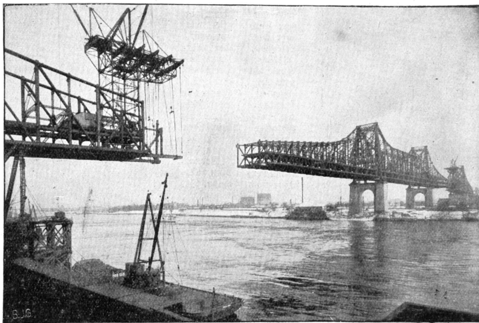
Der Bau der New-Yorker Eisenbrücke Brooklyn Blackwell-Inland.
