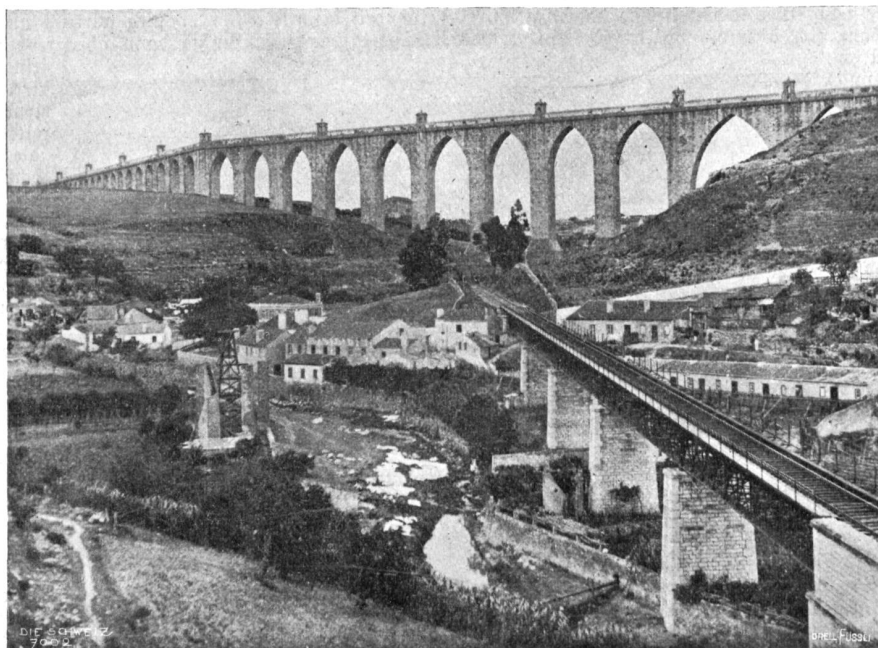
Alte Aquädukte in Lissabon.
