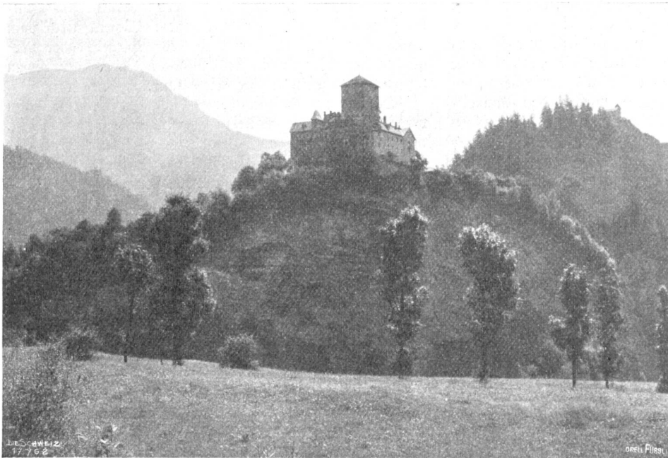
Schloß Ortenstein im Domleithg; rechts auf der Höhe die St. Laurenzenkapelle.
