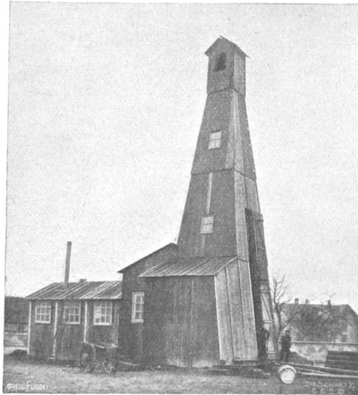
Bohrturm bei der Saline Ryburg bei Möhlin.
