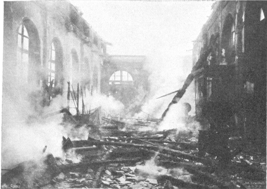
Das Innere der Halle des Genfer Bahnhofes während des Brandes.
