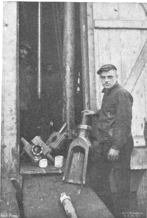
Bohrwerkzeuge und Blick in den Bohrturm.
