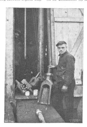
Bohrwerkzeuge und Blick in den Bohrturm.
