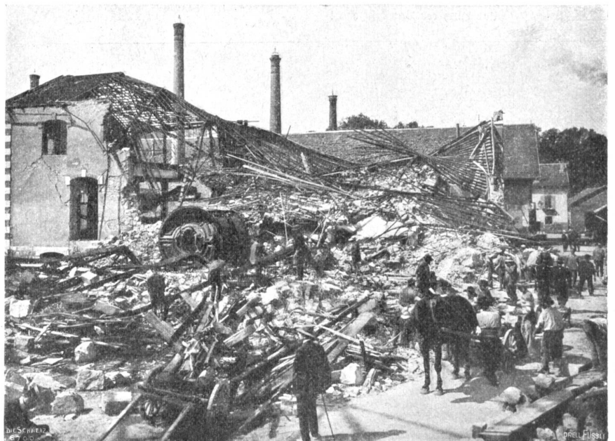
Explosion in Genf. Die zerstörten Laboratorien und Gasreinigungsgebäude. In der Mitte der Standart-Wäscheapparat, die mutmaßliche Explosionsstelle. Phot. Anton Krenn, Zürich.
