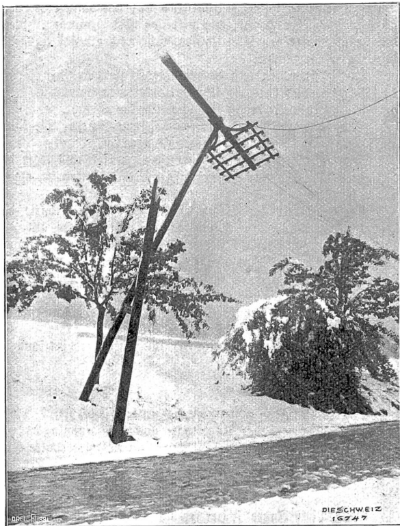
Vom Mai-Unwetter 1908. Durch Schneedruck gebrochene Telegraphenstange ob Fluntern-Zürich. — Phot. Otto Heierli, Zürich.
