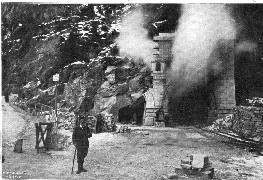
Oberingenieur Konrad Piffel vor dem Tunnelportal bei Zelle.
