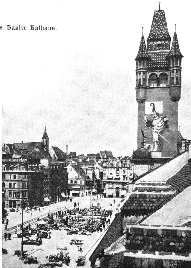
Das Basler Rathaus Abb. 3. Turm und Marktplatz (Phot. A. Krenn, Zürich).
