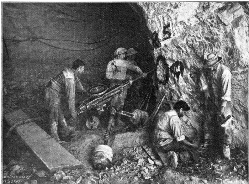
Im Jungfrauabthtunnel. Die elektrische Gesteinbohrmaschine in Tätigkeit (Phot. A. Krenn, Zürich).
