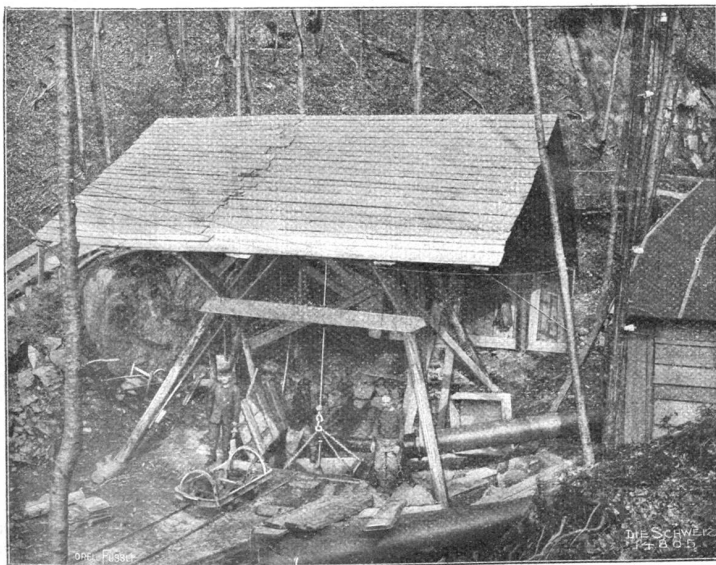
Ricken-Tunnelbau. Senkrechter Schacht zum Tunnel zur raschen Materialförderung. Von den Schächten aus wird der Tunnelbau nach beiden Seiten vorgetrieben.
