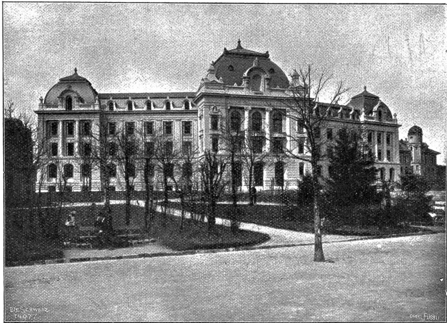
Das neue Hochschulgebäude in Bern (Phot. A. Krenn, Zürich).
