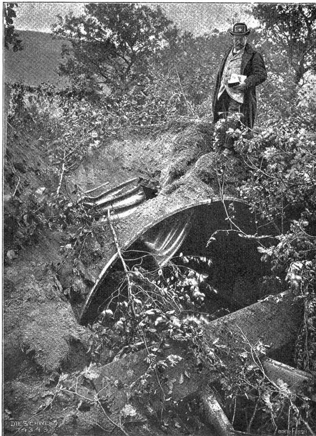
Befestigung am Zählkanal: Wirkung einer 12 cm Granate auf geschützte Infanterie-Unterstände (Phot. A. Krenn, Zürich).
