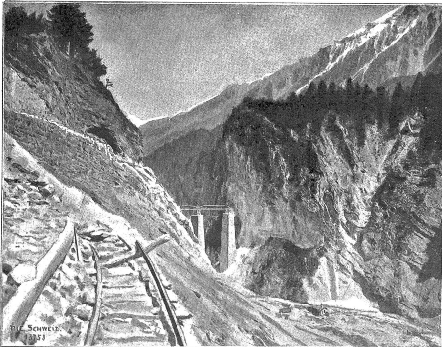
Ueberbrückung der Landwasserschlucht mittelst Viadukt von 130 m Länge und 65 m Höhe. (Phot. A. Krenn, Zürich).
