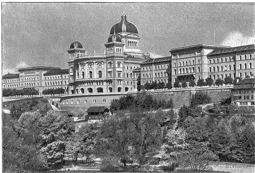
Südfassade des Bundeshauses von der Kirchfeldbrücke aus (Phot. Weber-Hauser, Wädenswil).
