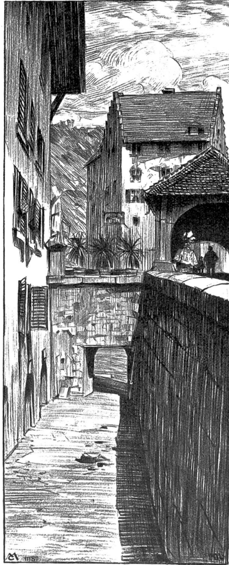
Die alte Brücke mit dem Landvogtschloß.
