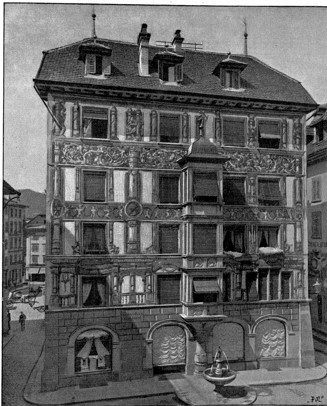
Haus des Herrn Goldschmied Boffard in Luzern. Fassade gegen den Hirschplatz. (Vergl. S. 301).
