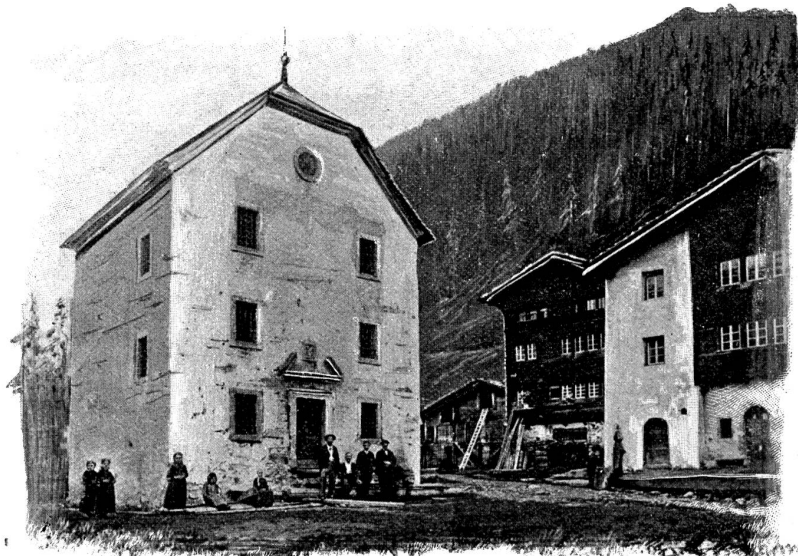
Das Rathhaus zu Ernen. Nach einer Photographie von Dr. F. G. Stebler, Zürich.
