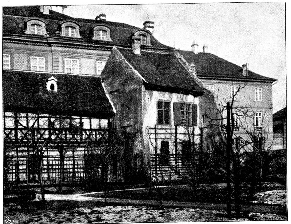
Das Hebelhaus in Basel vor seinem Abbruch im Jahr 1890. Nach Phot. von Prof. F. Burckhardt in Basel.
