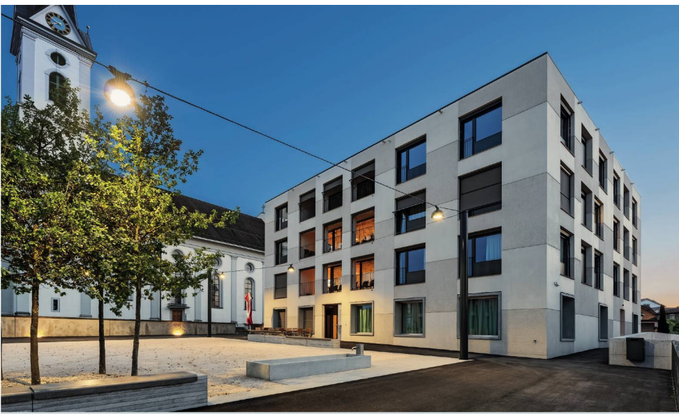
Zentrum Chileweg in Rain LU: «Der Bau beeindruckt und erfreut gleich auf mehreren Ebenen.»
