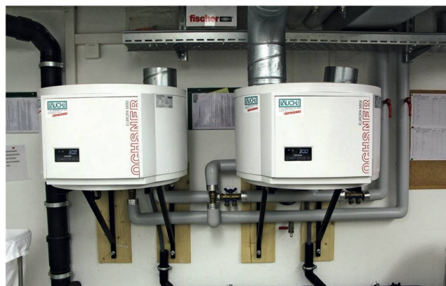
Wärmerückgewinnung: Warmwasseraufbereitung und Klimaanlage in einem.
