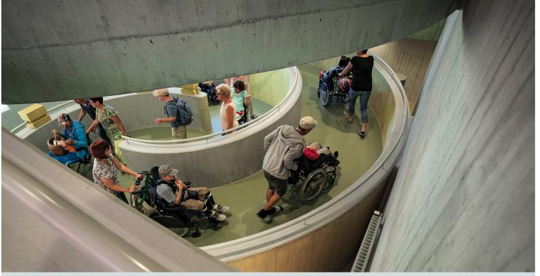
Komplett berrierefrei: Das vierstöckige Bauwerk ist mit einem spiralförmig angeordneten Rampensystem durchgehend verbunden.
