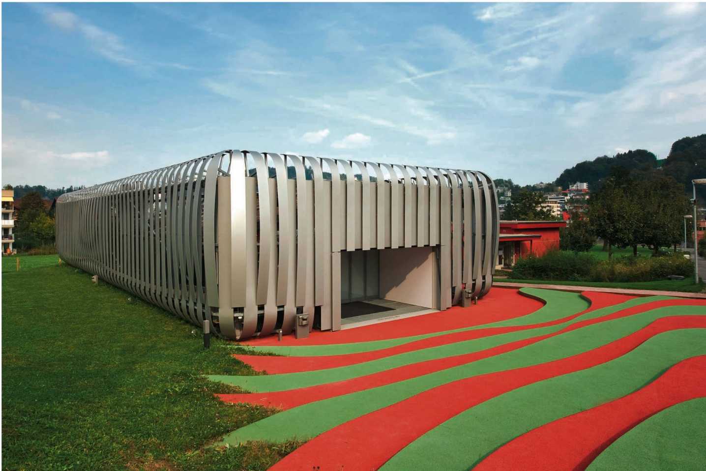
Das iHomeLab auf dem Campus der Hochschule Luzern in Horw: Das markante Gebäude mit seinen Silberlamellen ist unverwechselbar.
