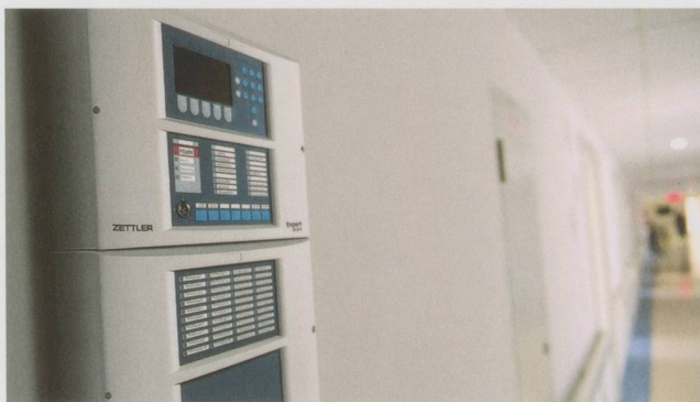
Eine Brandmeldezentrale wie ZETTLER® Expert von Tyco funktioniert mit zentraler Intelligenz. An das Brandmeldesystem können je nach Einsatz unterschiedlichste Meldertechnologien angeschlossen werden: von freiprogrammierbaren Mehrkriterien-Meldern bis zu Rauchansaugsystemen.
