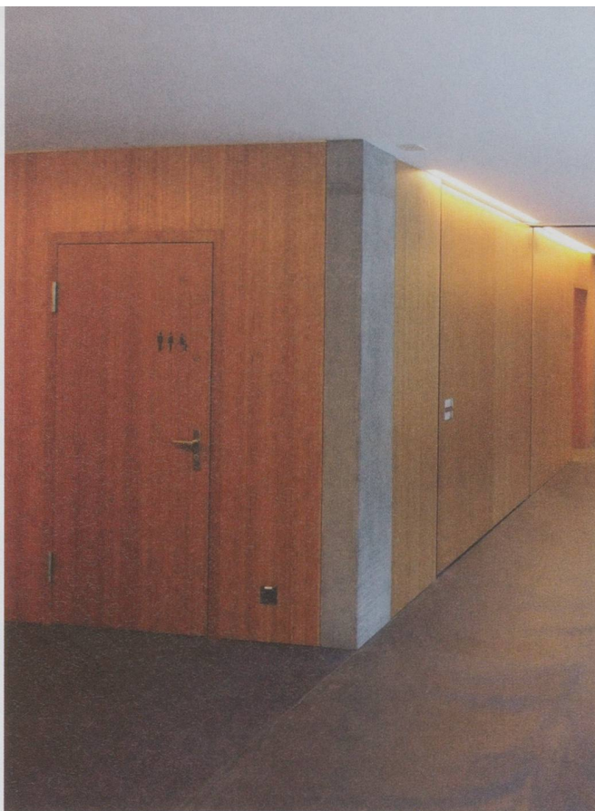
Türen bündig mit den Wänden und aus dem gleichen Material: Menschen mit einer Sehbehinderung haben keine Chance, ihr Zimmer zu finden (l.). Farbliche Kontraste, Türen innen angeschlagen und als Eingang «zelebriert»: vorbildlich (r.).
