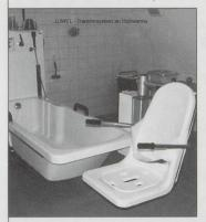
An Hubwanne zugebaut Liftsäule mit Bodenverankerung Badesitz als Transfereinheit:
