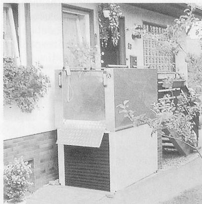
Da keine feste Installation erforderlich ist, kann der Lift jederzeit an einem anderen Ort wieder eingesetzt werden.
