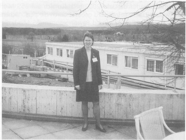
Überzeugt vom De Meeuw-Bettenstation-Pavillon: Die dynamische Verwalterin des Altersheimes Dietenrain in Uster, Frau Dobler-Müller, vor dem Pavillon auf der Baustelle des Neubaus.
