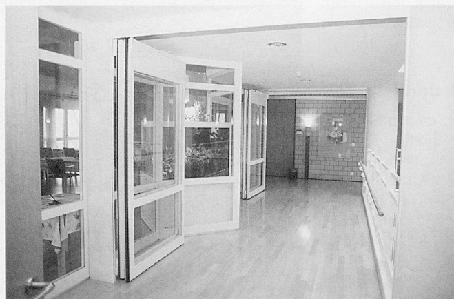
Offene, ungehinderte Durchgänge im Normalfall und automatisch geschlossene Brandschutztüren bei Brandalarm.
