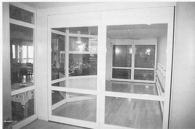
Offene, ungehinderte Durchgänge im Normalfall und automatisch geschlossene Brandschutztüren bei Brandalarm.
