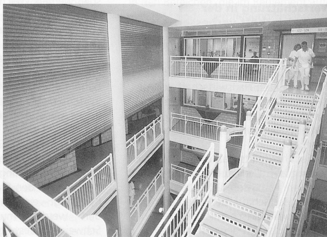
Im Alarmfall schliessen sich beiderseits des «Innenhofes» die Brandtüren, wobei vor allem die Brandrolltüre beeindruckt.
