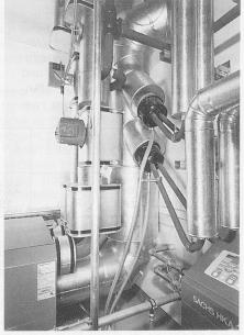
Von links nach rechts: Der Spitzenkessel mit Gas/Öl-Zweistoffbrenner. Auch der Speicher findet noch im Heizraum Platz (hinten eines der Mini-BHKWs). Einfache, durchdachte Vermeidung von Körperschall-Übertragung: Gesteckte Abgasrohre, flexible Schläuche, isolierte Rohrschellen.
