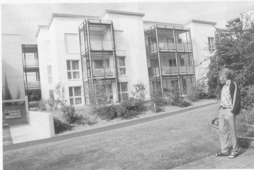
Neues Gesicht und neues Innenleben – neue Alterswohnungen: Das Heim selber (links) wurde totalsaniert und erhielt mit einer neuen, vorgezogenen Fassade bedeutend grössere Zimmer, neu dazu kam die Alterssiedlung mit den Alterswohnungen. Im Bild nicht sichtbar ist der derzeit im Bau befindliche Trakt für die Wohngruppe, welcher südlich mit einer direkten Verbindung an das Heim anschliesst.
