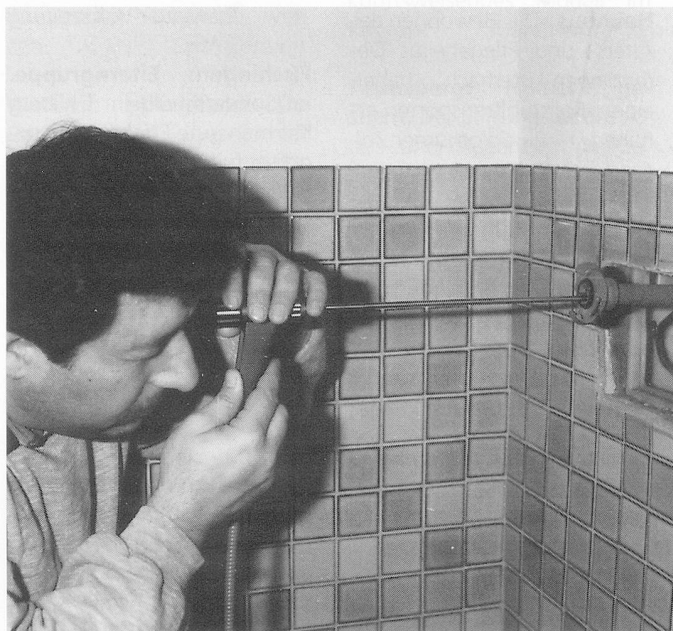
Sorgfältig überprüft der LT-Spezialist die Sanierungsarbeit mit dem Endoskop, denn nur sorgfältige Arbeit gewährleistet die Qualitätsgarantie nach SIA-Norm 118.
