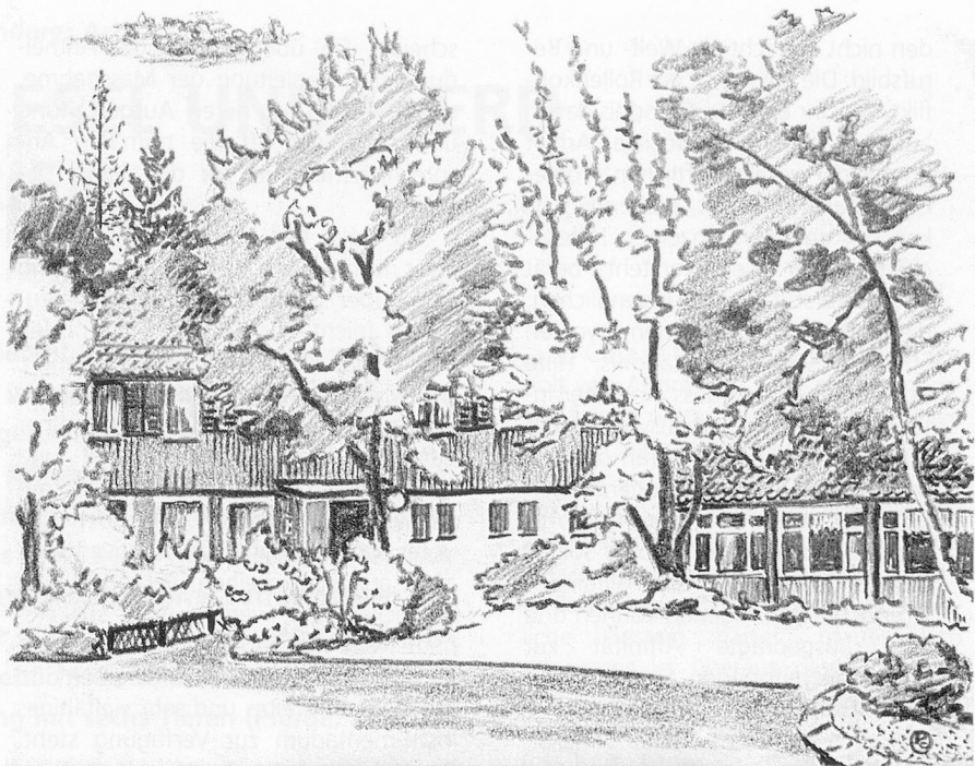
Teilansicht der Jugendstätte Gfellerghut, Zürich (Hauptgebäude).
